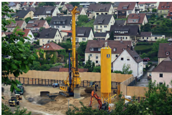
Entsorgung kontaminierter Boden
