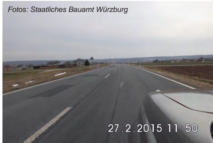
Einmündung Kirchstraße vorher
