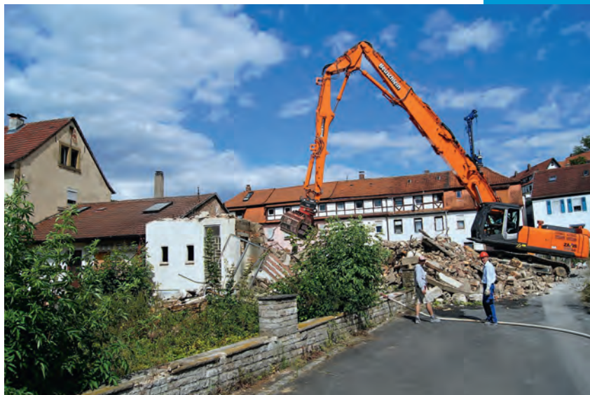
Gebäudeabbruch zur städtebaulichen Neuordnung
