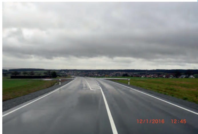
Einmündung Kirchstraße nachher
